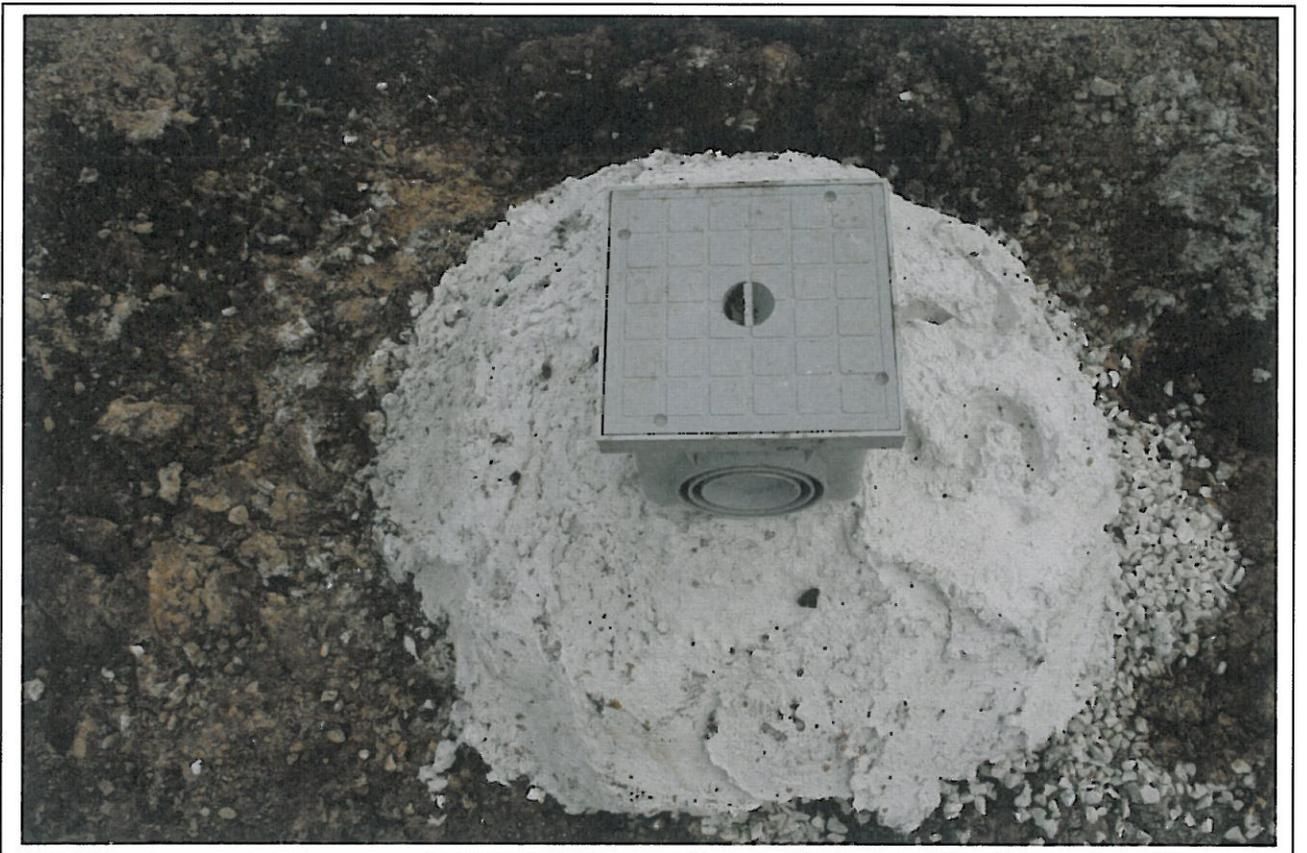
**PREDISPOSIZIONE SONDAGGIO SISMICO DOWN HOLE**
